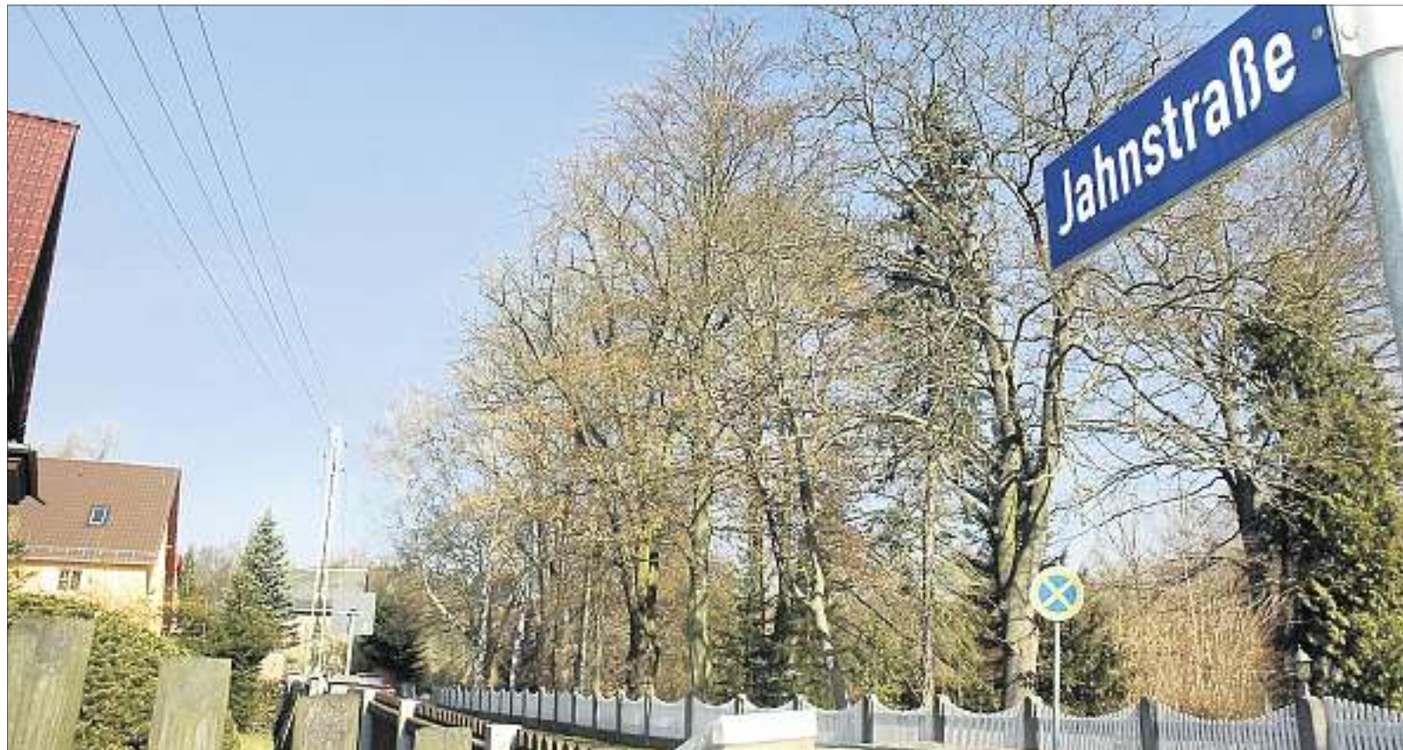
Die überirdischen Stromleitungen in der Jahnstraße in Bad Klosterlausnitz sollen in einem weiteren Bauabschnitt ins Erdreich verlegt werden. Derzeit sind nach Angaben von Eon, mit denen die Gemeinde einen Konzessionsvertrag schließen wird, 70 Prozent aller Stromkabel der Gemeinde im Erdreich. Foto: Andreas Schott
