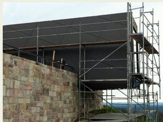
Für die Fassade des eingeschossigen Besucherzentrums wurden Faserzementplatten mit einer schlichten grau-braunen Färbung gewählt, um das Gebäude dem Burgbestand dezent unterzuordnen. Die schrägen Plattenfugen verstärken auf einfache Weise die dynamische Form des Baukörpers. Material, Farbe und Linienführung ordnen sich der Corporate Identity des Ausstellungskonzeptes unter und sind nach Fertigstellung der gesamten Baumaßnahme in weiteren Teilen der Burg wiederzufinden.
